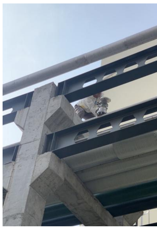
废气采样口 C
